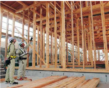
現場の最前線で働く社員の皆さん。このような作業中に大災害が来る可能性もある。
